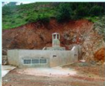
HAMMAM BOURGUIBA : Toit de la nouvelle chambre de captage
